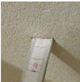
Sehr hohes Standvermögen, Putzlagen bis zu 12 mm
